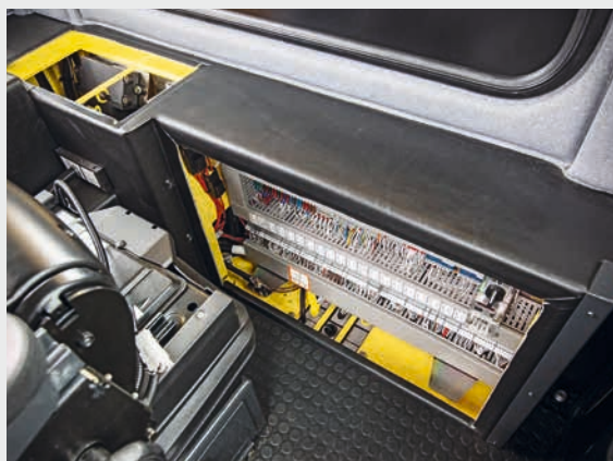
Central de mando perfectamente protegida en la cabina.
