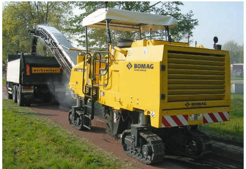
Extracción en un solo ciclo de trabajo de las capas portante, de ligante y de desgaste en obras de canalización.
