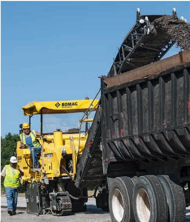
En la rehabilitación de calzadas de las carreteras regionales, las capas dañadas se retiran de forma selectiva. Unas marcas bien visibles en las placas laterales facilitan una colocación precisa.
